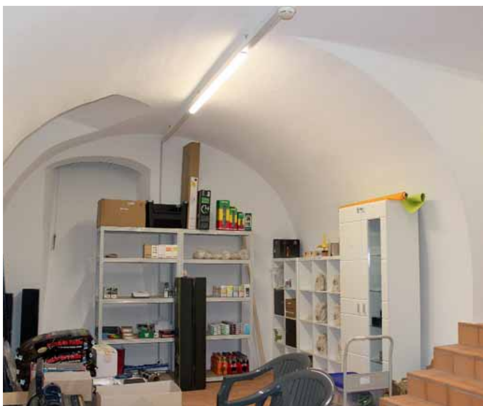
▲ Gewölbekeller Schellenhaus, Bremgarten AG, nach Mauerwerksanierung
