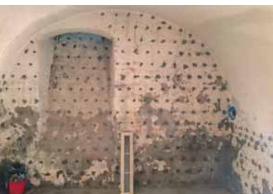
▲ Gewölbekeller Schellenhaus, Bremgarten AG, vor Mauerwerksanierung 2021
