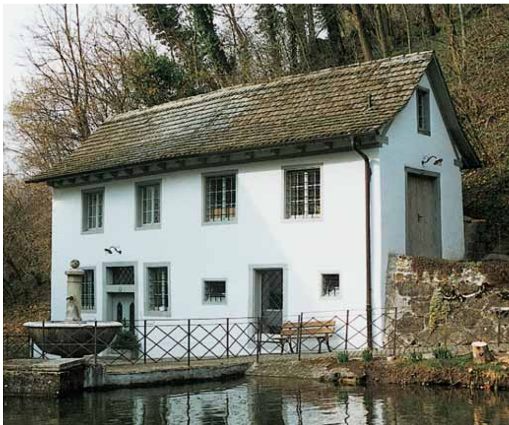
▲ Alte Mühle, Grüningen ZH, nach Mauerwerksanierung (Aufnahme 2021)
