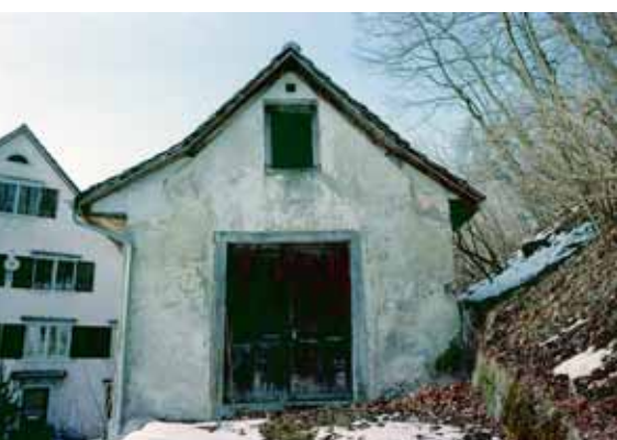
▲ Alte Mühle, Grüningen ZH, vor Mauerwerksanierung 1988
