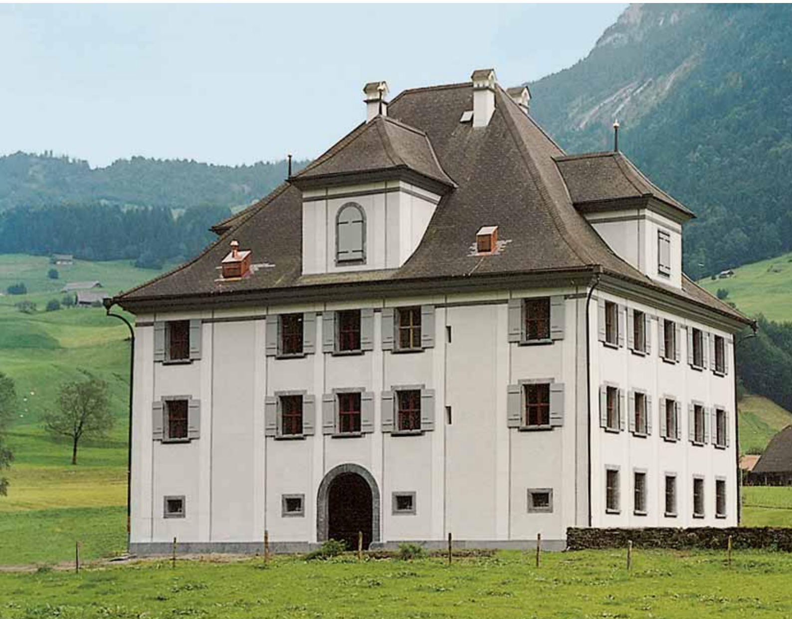
▲ Herrenhaus Kloster Engelberg, Grafenort (OW), 16 Jahre nach der Mauerwerksanierung
