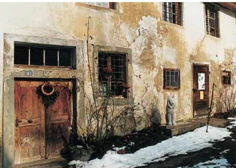
▲ Alte Mühle, Grünigen (ZH), vor der Mauerwerksanierung (1988)
