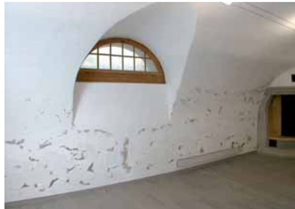
▶ Beispiele diverser Formen von Verfärbungen, Ausblühungen und Abplatzungen infolge aufsteigender Feuchtigkeit
