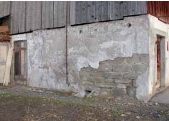
▶ Beispiele diverser Formen von Verfärbungen, Ausblühungen und Abplatzungen infolge aufsteigender Feuchtigkeit
