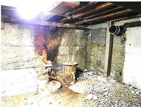
Lokale Durchfeuchtung und Schimmelbefall Aussenwand
