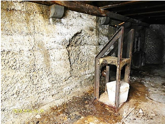
Kiesnester, Ausbrüche Mauerwerk und Schimmelbefall Mauerwerk
