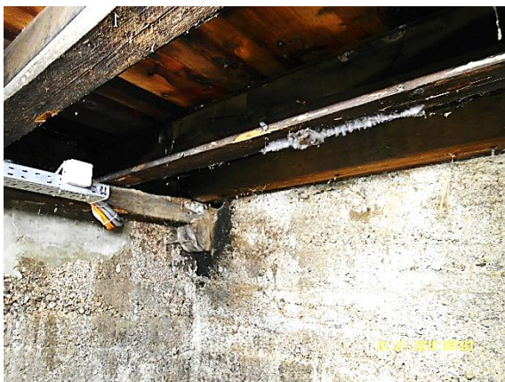
Feuchte und nasse Holzbalken und Bretter mit lokalem holzerstörenden Schimmelbefall
