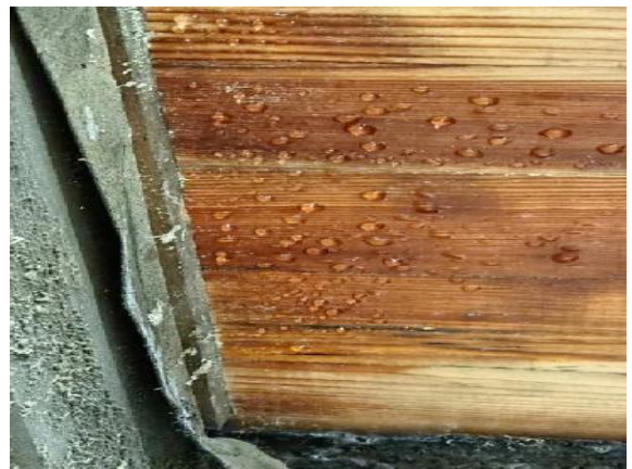
Kondensat an Holzboden
